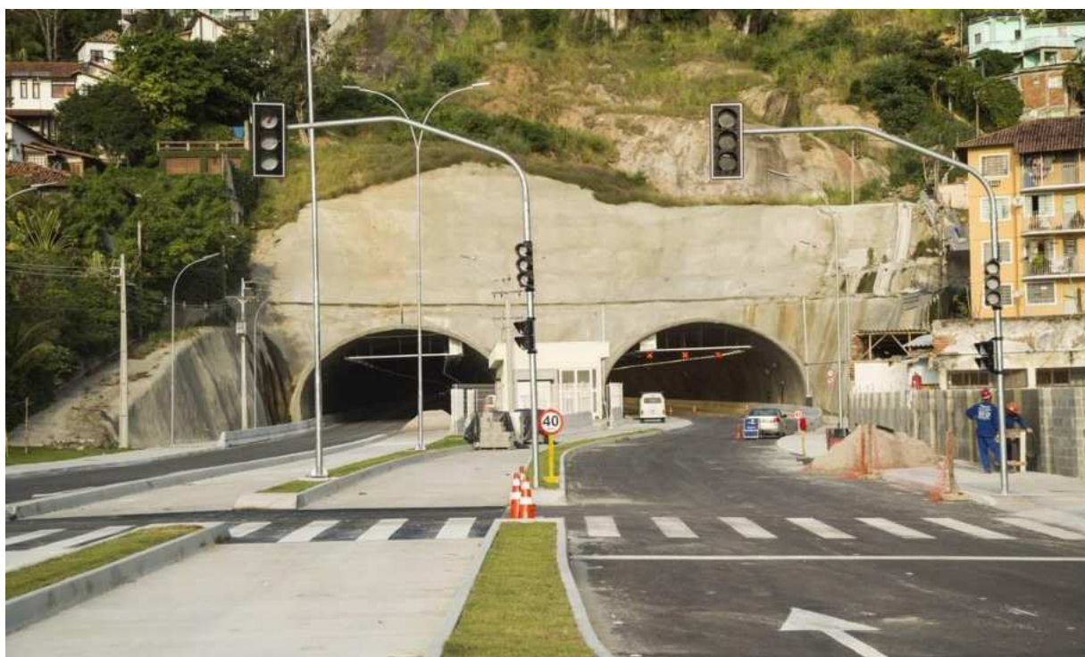
Figura 5: Foto da entrada do Túnel Charitas-Cafubá
