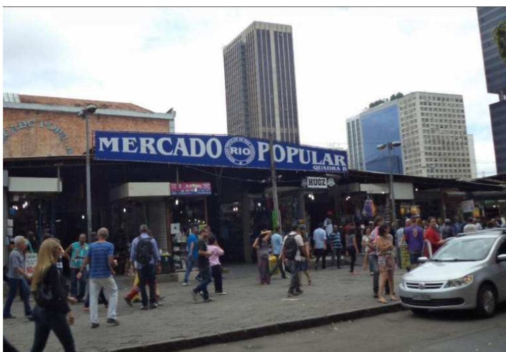
Figura 33 - antiga fachada do Camelódromo da Uruguaiana (hoje com nome alterado para Centro Comercial Uruguaiana).
