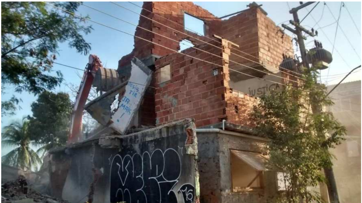
Fotografia 6 – Casa sendo demolida na Rua Gilles Villeneuve: “Desistir jamais!”, 1º de agosto de 2016. Fonte: Acervo do Museu das Remoções. Fotografia de Luiz Cláudio da Silva.
