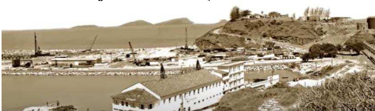
Figura 11- Obras de construção da Petrobras em Macaé
