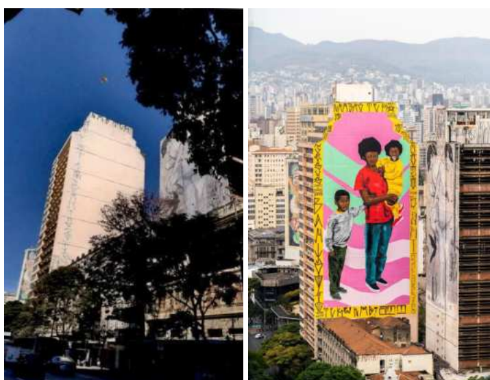
Figura 9: Antes (lado esquerdo) e depois do edifício Itamaraty (lado direito)
