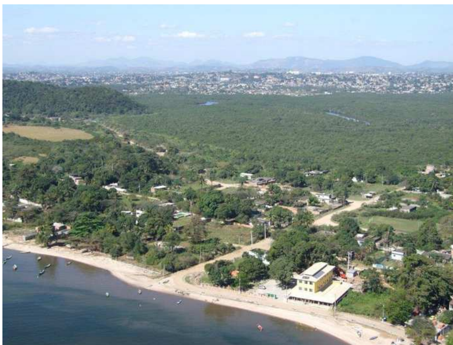
Fig. 8 – Vista aérea parcial de Itaoca
