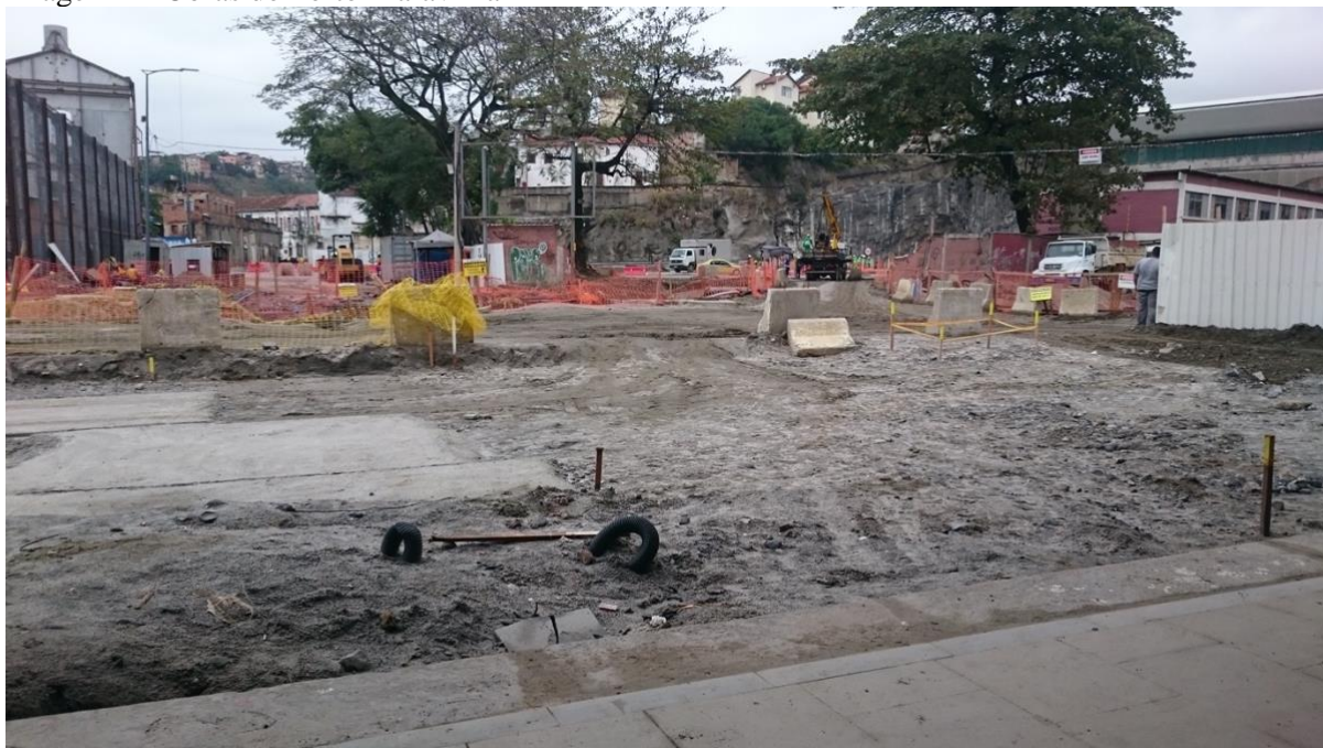
Imagem 4 - Obras do Porto Maravilha
