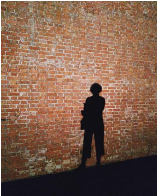
Imagem 8 - Detalhe parede de tijolo de barro
