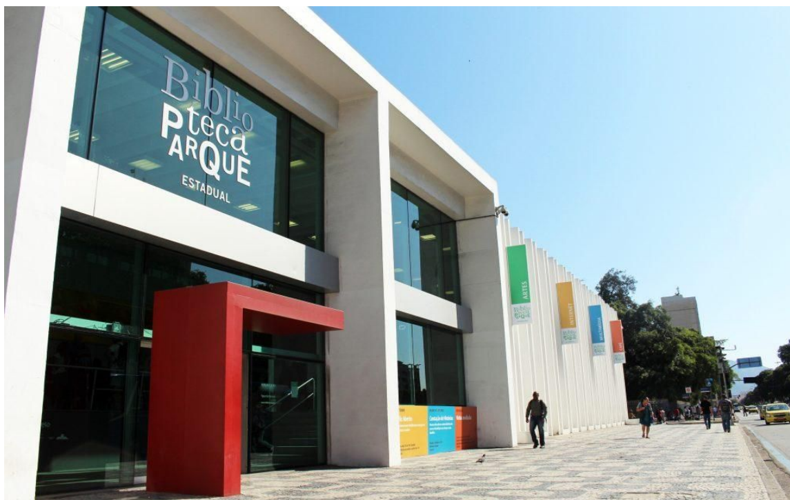
Fig. 14 (Fachada da Biblioteca Parque Estadual)
