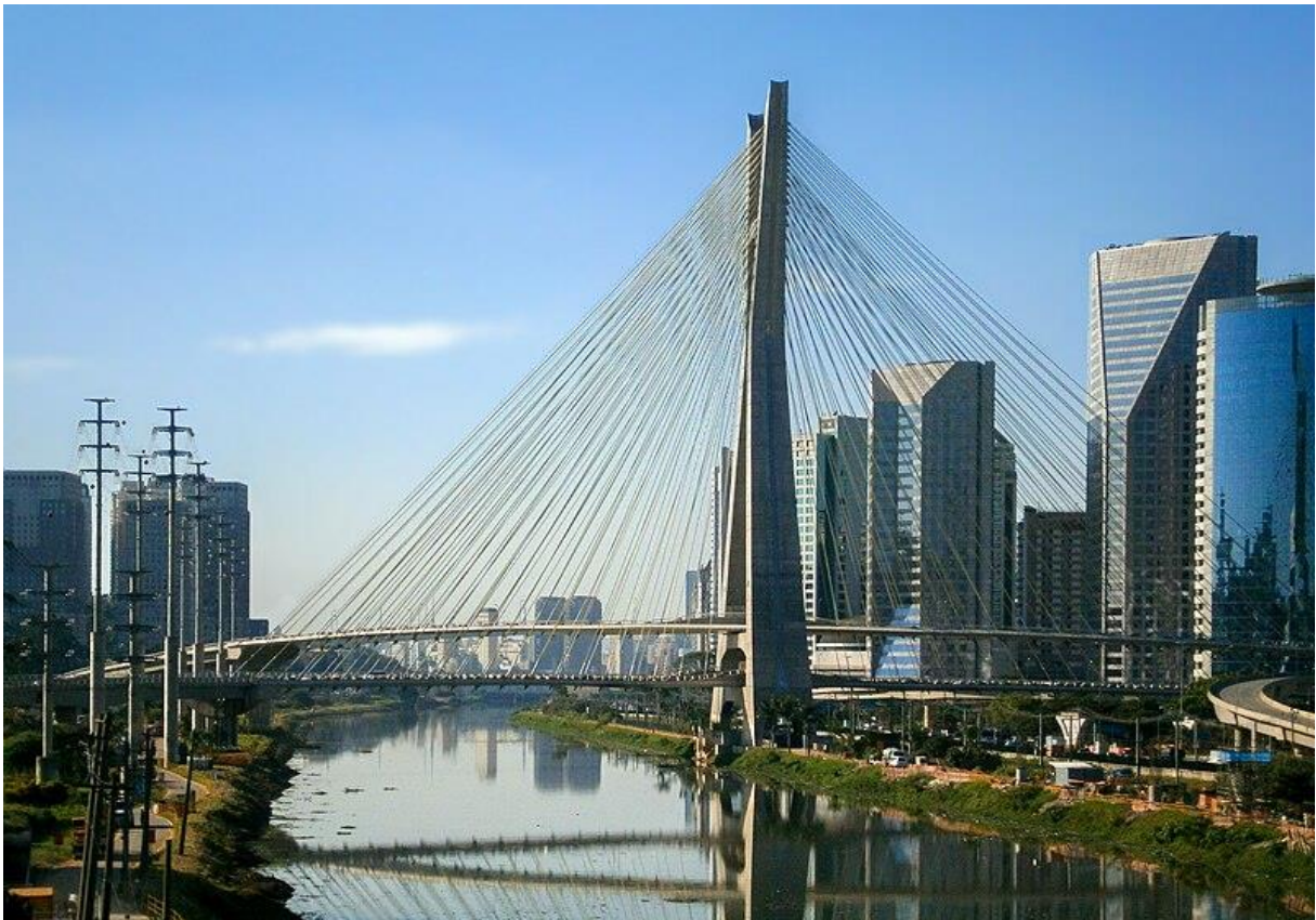
Imagem 2: Ponte Estaiada Octávio Frias de Oliveira
