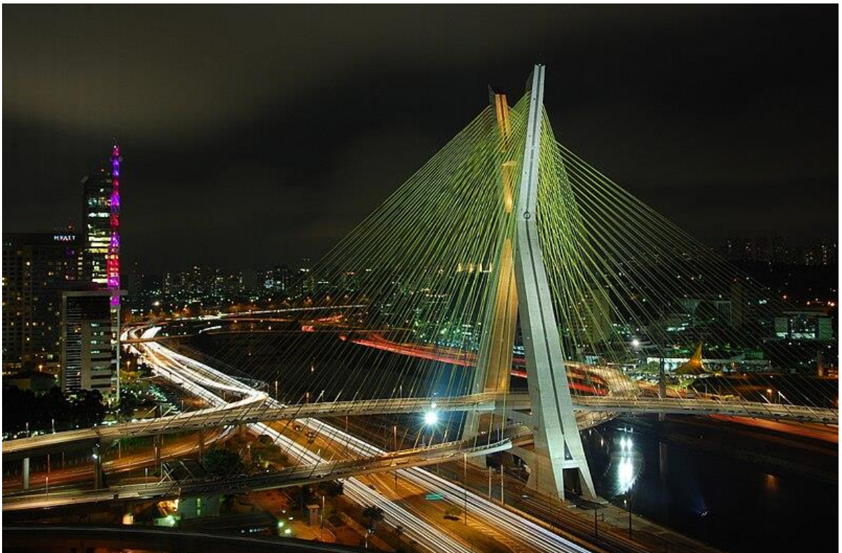
Imagem 4: Ponte Estaiada Octávio Frias de Oliveira III
