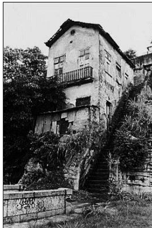
Sobrado de serviço do séc. XIX adaptado / sem estilo definido / Casa da Guarda / 2008
