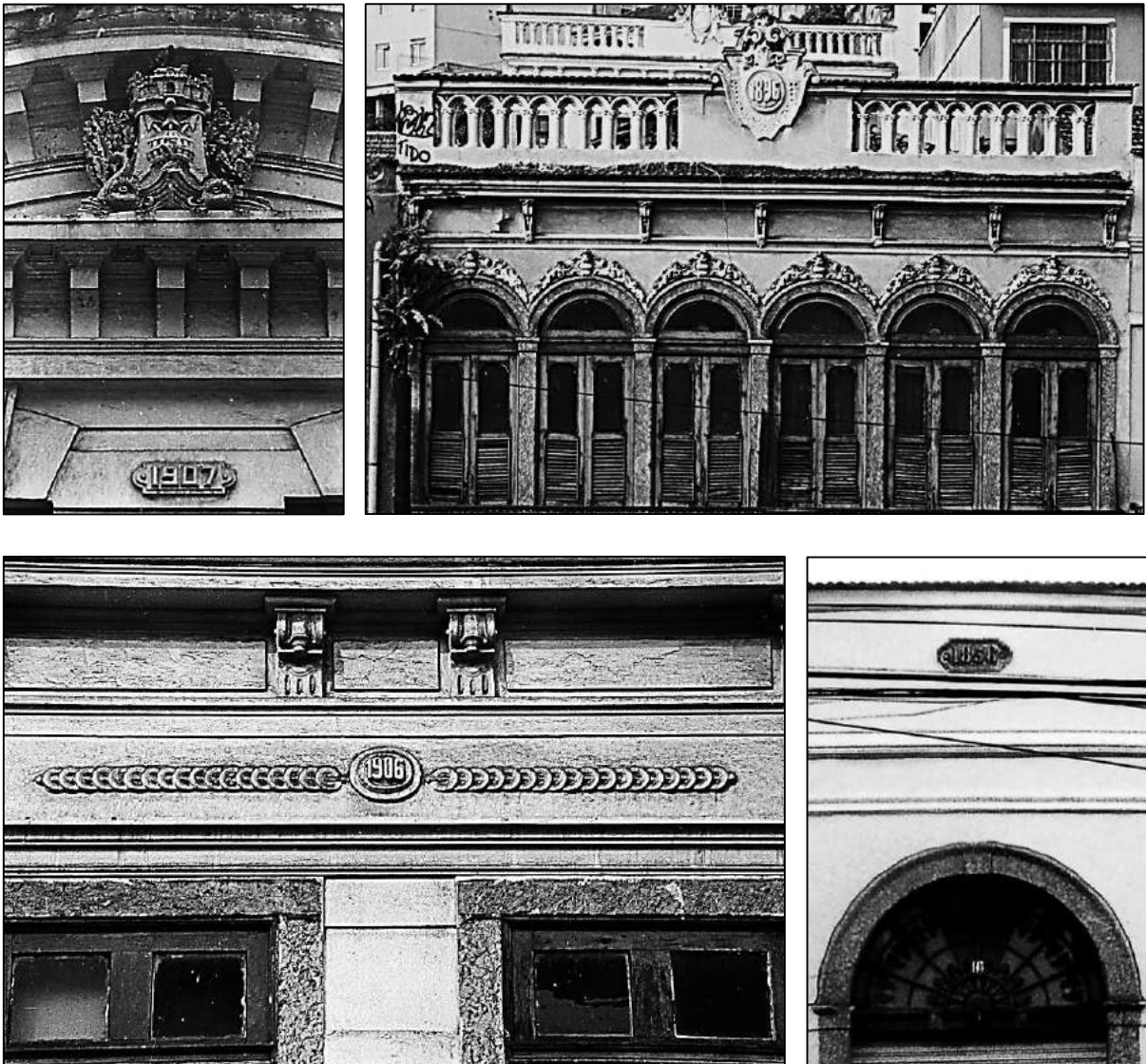
Datação nas fachadas – Fotos: ano 1907 num edifício com ornamentos ecléticos na Rua Camerino (2009); ano 1896 num sobrado com ornamentos em art-nouveau na Rua Camerino (2008); ano 1906 em um sobrado em estilo art-déco na Rua Camerino (2008); ano 1856 numa casa em estilo neocolonial (2012).
