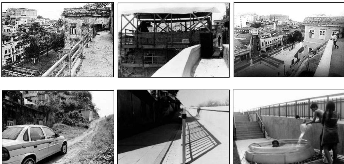
Transformação do espaço. Ressignificação do espaço com as reformas do Projeto Porto Maravilha, mudança nas circulações e no uso do lugar. Fotos: (em cima) Casa da Guarda em três momentos, antes durante, depois da reforma do Projeto Porto Maravilha; parte final da Ladeira do Morro do Valongo ainda de barro (2008-2012)
