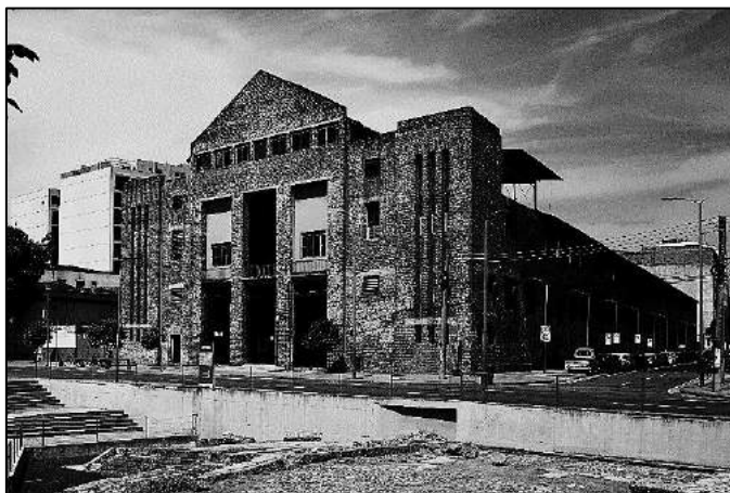
Docas D. Pedro II , projeto por André Rebouças, o prédio em estilo das construções inglesas com a estrutura metálica e com os tijolos expostos , construído no final do séc. XIX, fundado em 1871. Tinha finalidade de armazenar o estoque de exportação de café. Por exigência do engenheiro (afrodescendente), não foi usada mão de obra escrava, com operários contratados, numa época ainda vigorava o sistema escravista no Brasil. Ano / 2014
