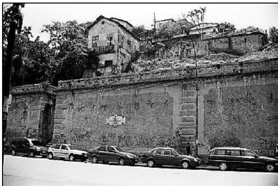
Muro do Jardim Suspenso do Valongo vista da Rua Camerino / 2008
