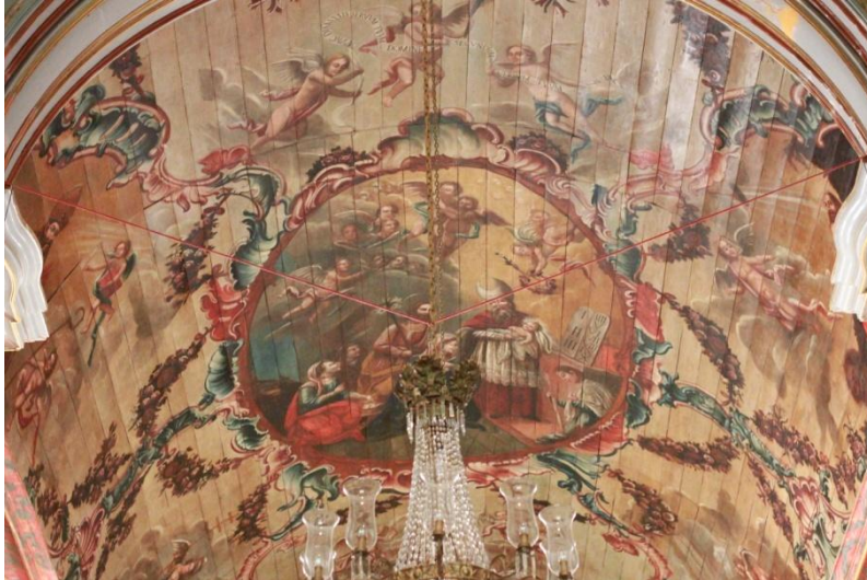
Teto da nave principal, Igreja Matriz (2015) – Itu. Fonte: Fotografia original Lucas Garcia Nunes
