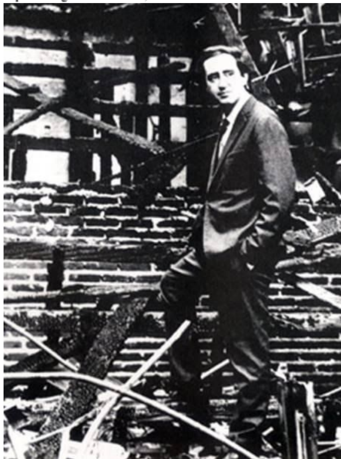
Figura 18: Zé Celso em meio aos escombros em 1966. Fonte: Arquivo Edgard Leuenroth, UNICAMP.
