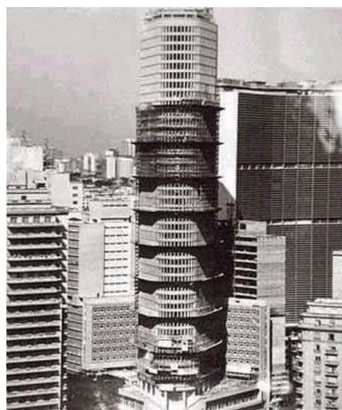
Figura 43: Edifício Itália em construção, em 1963. Fonte: Sao Paulo In Foco.
