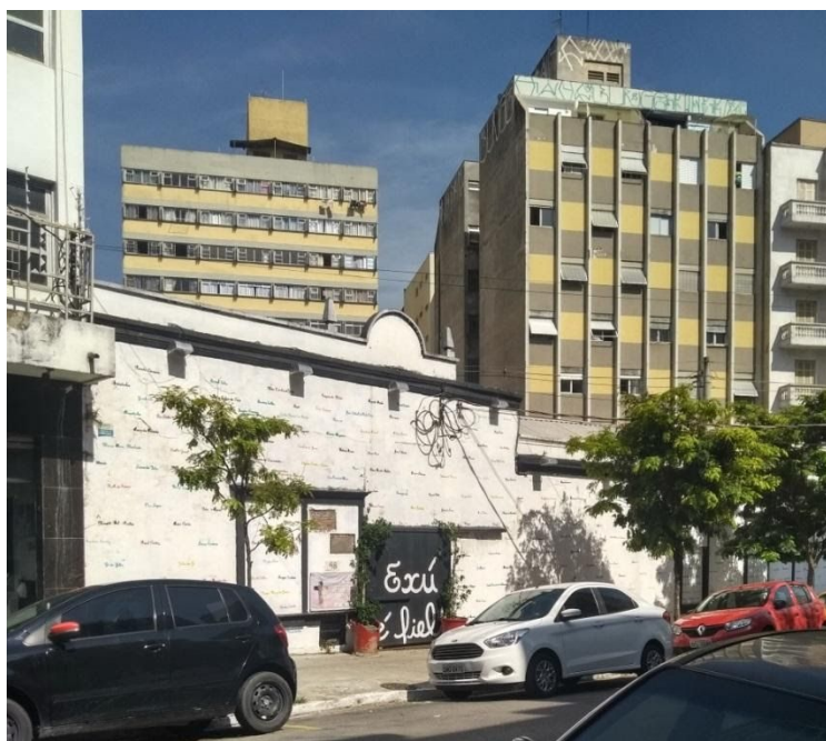
Figura 2: Lateral do Teatro do Incêndio na Rua Treze de Maio no Bixiga.
