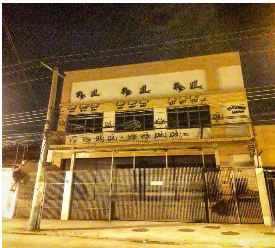
Fig. 12. Dacora e Vok, pixações realizadas no ponto mais alto do prédio através da escada pelas janelas. Abaixo, na lateral, frase com um grito local de galeras do bairro “Cachambi terror”.
